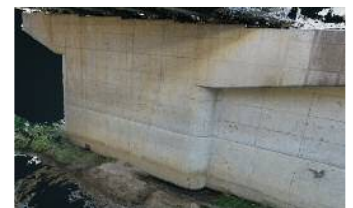
点群データ（橋脚）
