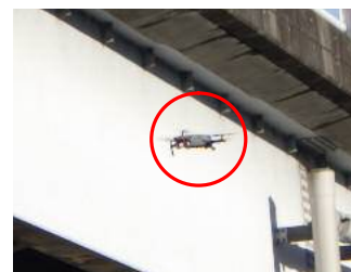
写真-2 点検状況
