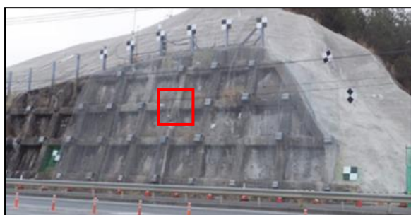
図 3 研究対象の法面（起点側）
