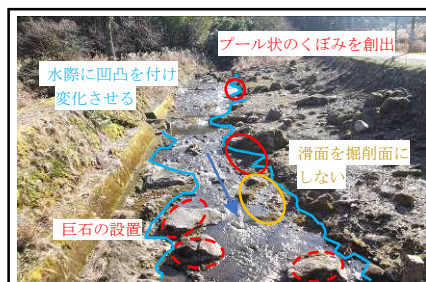
図-8 施工要領の追加 『岩掘削時の多様な河川環境の創出』
