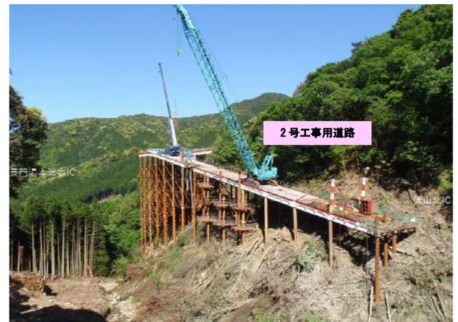
写真-5 仮設道路施工状況(仮橋)
