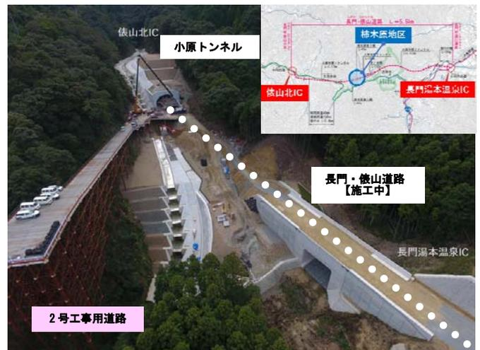
写真-4 仮設道路を利用した施工状況
