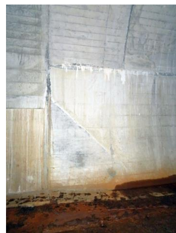
写真-3 断面変化部の摺付
