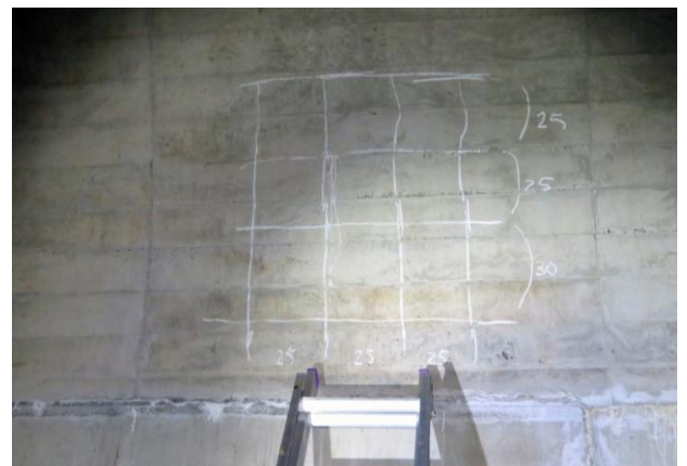
写真-6 鉄筋探査結果をコンクリート面に記入
