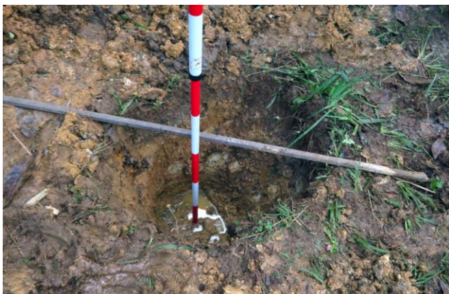
写真-4 約70cm掘削し、トンネル天端を確認
