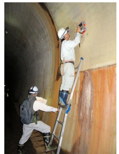
写真-5 RCレーダーによるトンネル内での鉄筋探査
