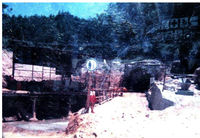
写真-1 建設中の下長屋トンネルの中間地点における今福側坑口（所蔵：中村勝征氏）
