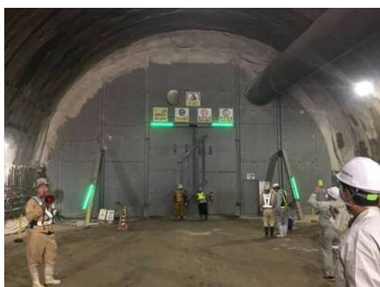
（広島高速 5 号線 NATM トンネル）
