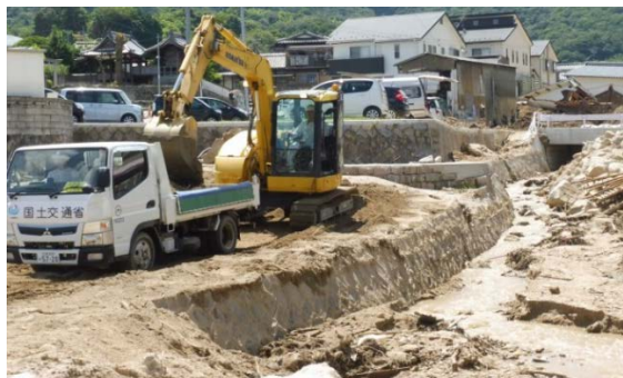
（写真-1）平成 30 年 7 月豪雨 土砂撤去作業（坂町坂西）
