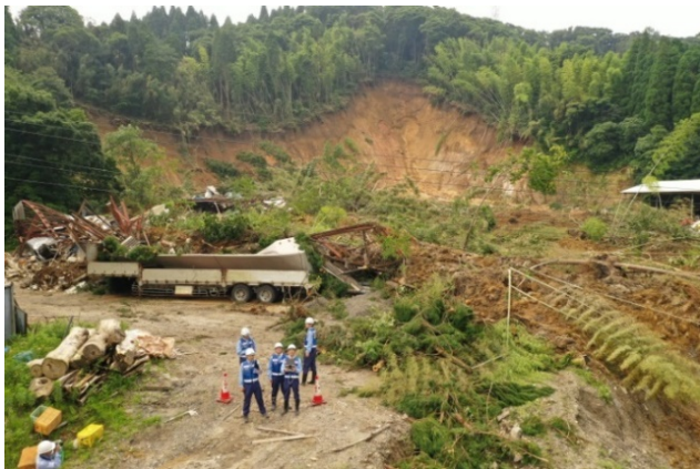
（写真-4）ドローンを用いた被災状況調査（鹿児島県鹿屋市）
