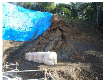
写真-1 流れ盤斜面における変状発生例 (北向き法面に分布する泥質片岩)
