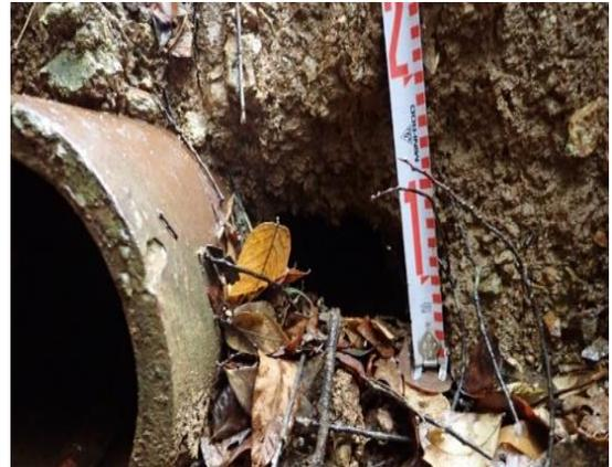
図-1 排水管周辺に発生したパイピング孔の状況(山口県内のため池)
