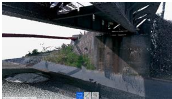
図3 広西大川橋梁の点群データ
