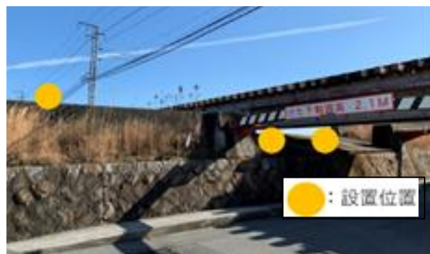
図2 広西大川橋梁のスキャナー設置位置
