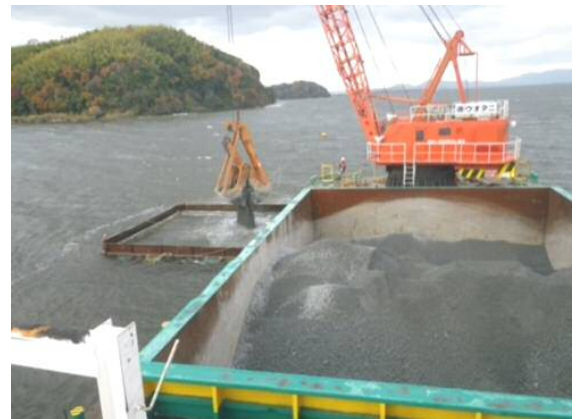
図－5 中海覆砂施工状況
