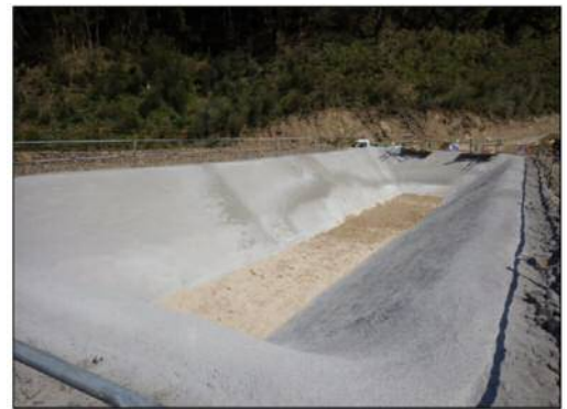
写真-2 仮設ピット全景写真
