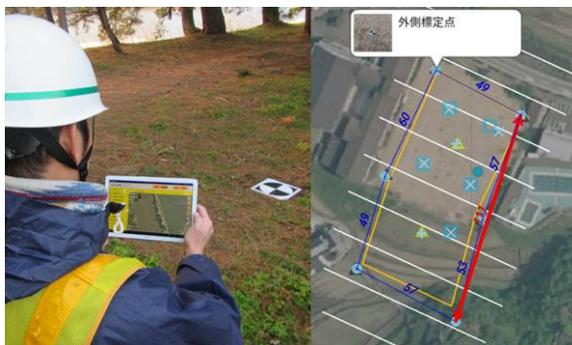
図 5 対空標識設置作業
