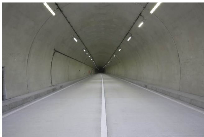
図-5 トンネル内照明点灯状況（入口照明）
