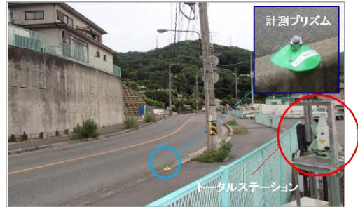
図-6 地表面変位の自動追尾計測（TS）
