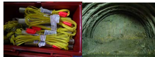
図-9 特殊電子雷管（eDev II）（左）と配管状況（右）
