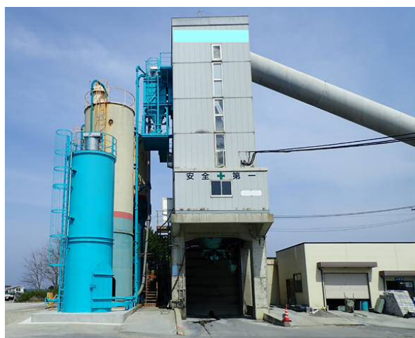
写真-1 F Aコンクリート用に改造した工場
