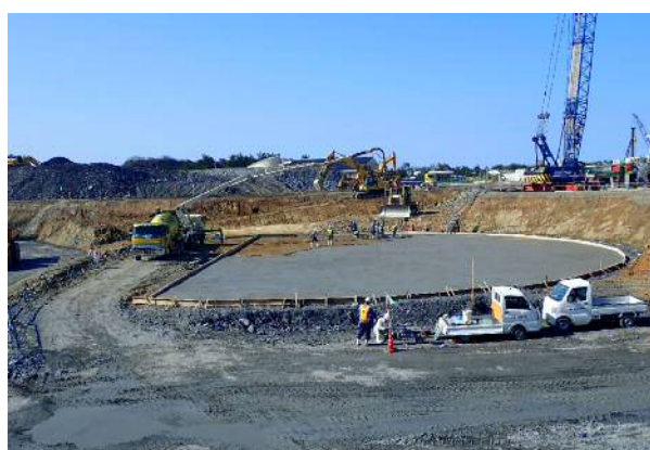
写真-2 F Aコンクリート打設状況 （石炭貯蔵設備）
