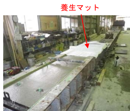
写真-1 打込み面の養生
