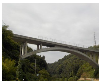
写真-1 四十八瀬川橋
