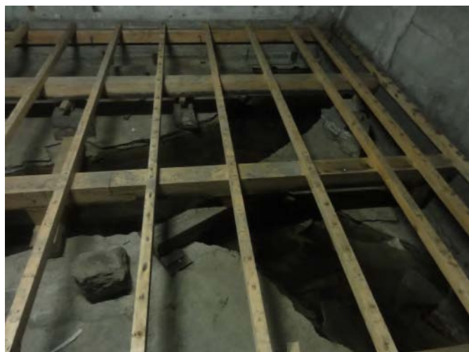
図6 指揮連絡室の床の様子
