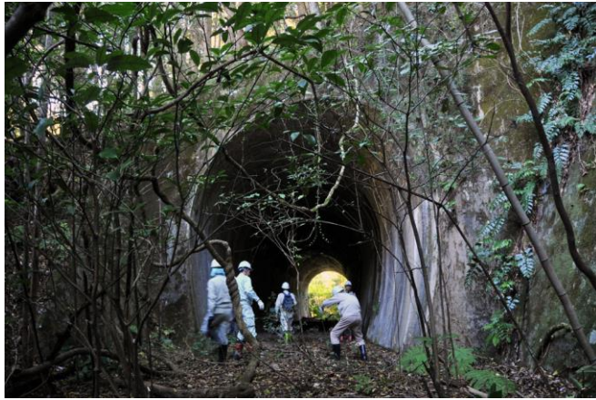
写真-1 初めて確認された有福第四トンネル
