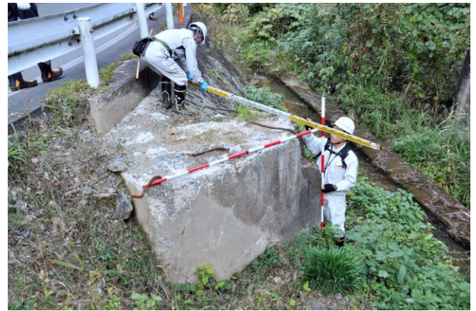
写真-2 有福第三トンネル付近の橋台計測
