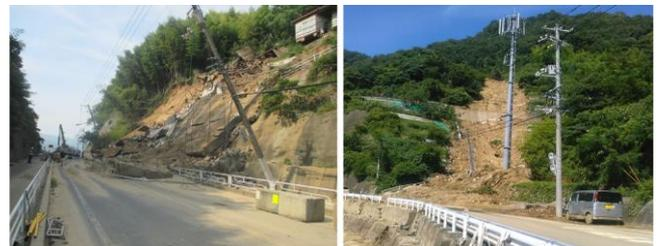
写真-2 県道 279 号が通行止めとなったもたれ擁壁崩壊(左・**図-2**中番号 1)と斜面災害(右・**図-2**中番号 2)
