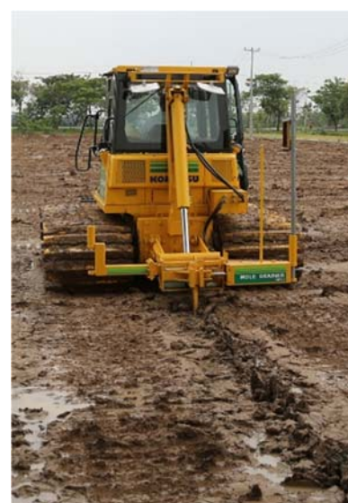
図-4 シートパイプ設置の状況
