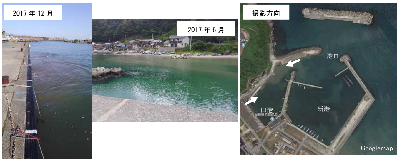
図-2 泊地堆砂状況
