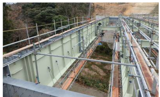
写真-1 架設状況
