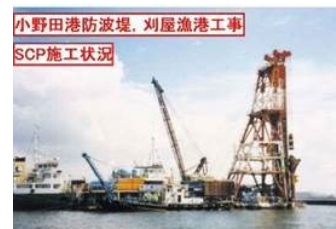
写真 2 地盤改良材としての施工状況
