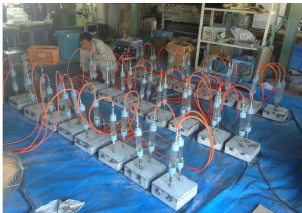
写真-1 亜硝酸リチウムの圧入状況
