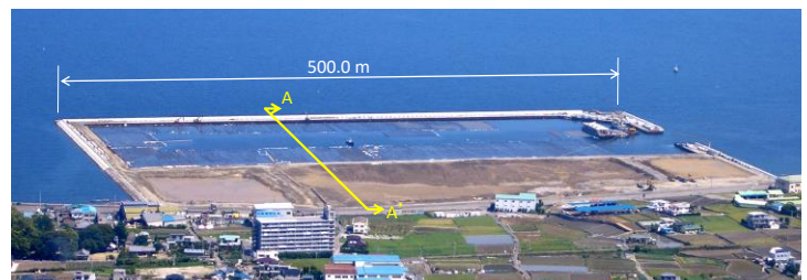
建設中の寒川産業廃棄物処分場 (2008)
