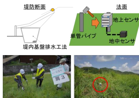
図-7 法肩センサ設置方法
