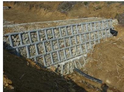
図-2 ガンロック工法による法面施工例
