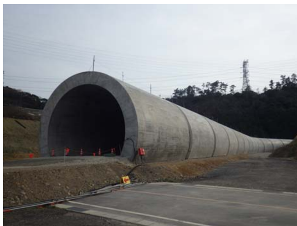
写真-1 アーチカルバート
