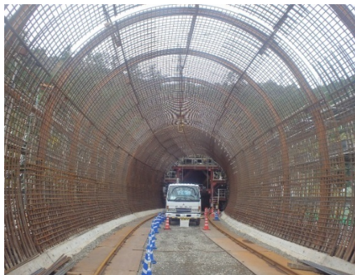
写真-3 鉄筋先行組立状況
