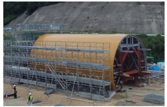
写真-2 スライドセントル
