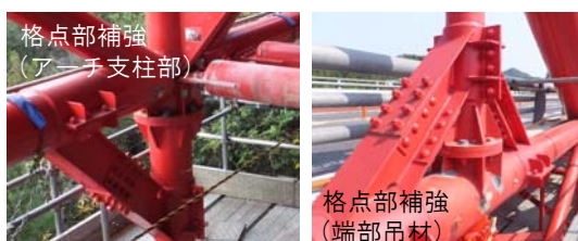
写真-2 応急対策工
