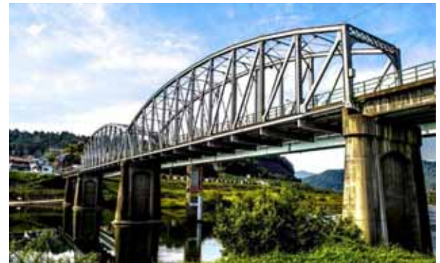
写真-1 対象橋梁の概観
