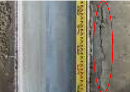
図-5 堰柱の劣化状況（P8 西面）
