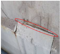
図-4 門柱の劣化状況（P8 西面）
