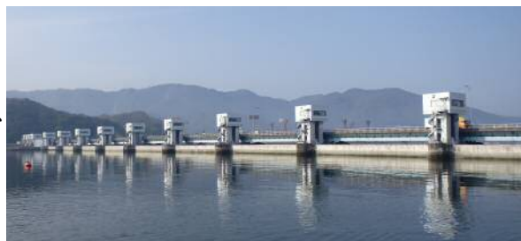
写真-1 芦田川河口堰全景
