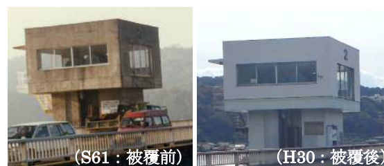
写真-4 表面被覆工された河口堰
