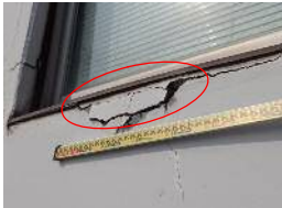
図-3 上屋の劣化状況（P8 南面）
