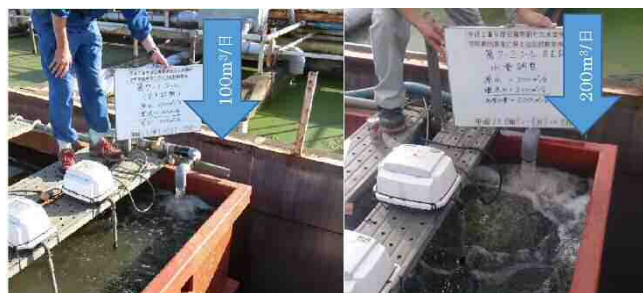
写真 1 第 2 槽における還流状況(左: 100m 3 /日, 右 200m 3 /日)
