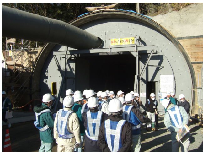
工事概要説明状況（神辺トンネル）
