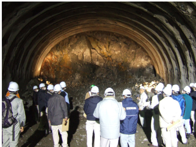
切羽視察状況（赤石トンネル）
