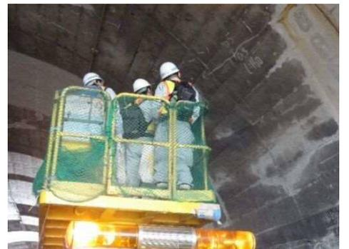
写真-2 トンネルの近接点検
