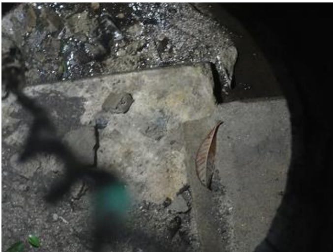
図3 防空作戦室に隣接する構造物の内部
