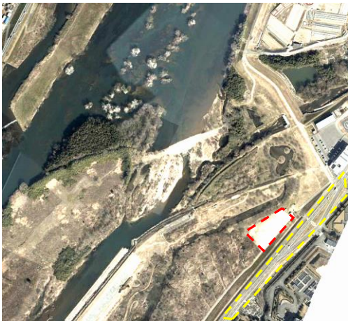
図-4 分流部周辺の航空写真(赤破線:裸地 黄破線:道路)
