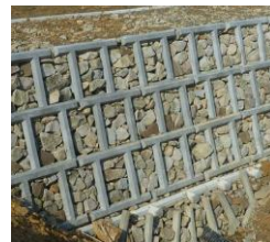
図-2 ガンロック工法による法面施工例
