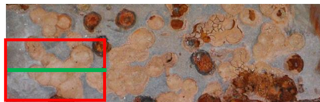
図3 腐食促進試験後の供試体
