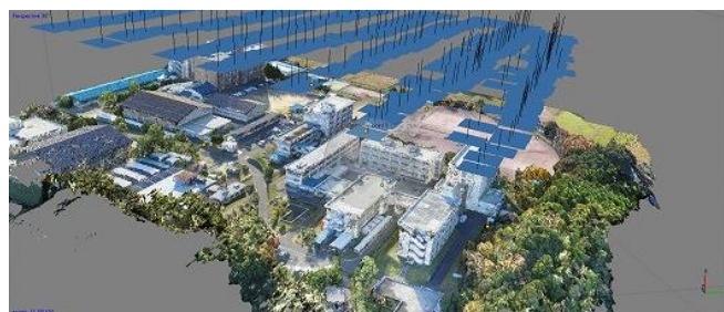
図-7 松江高専敷地三次元点群データ
