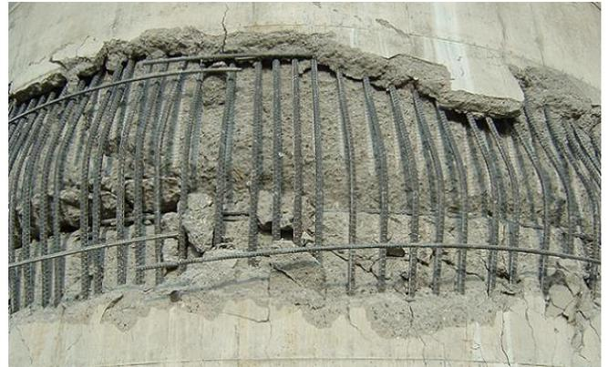
写真2 段落し部の拡大
