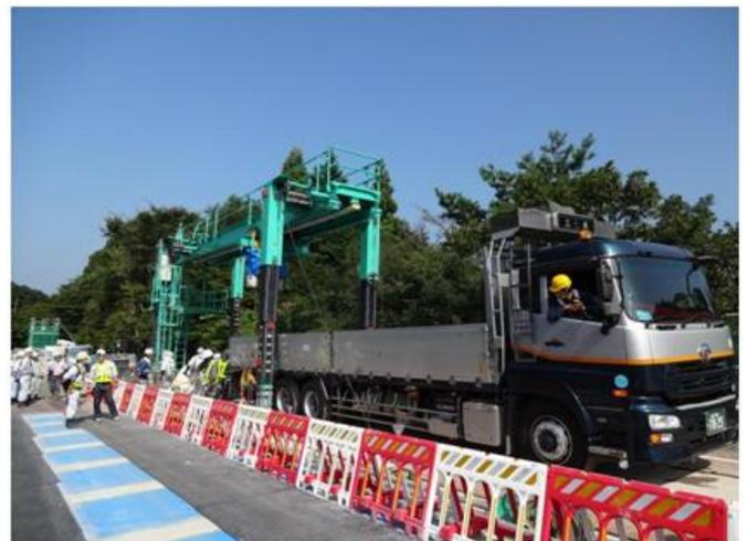
図-6 架設機による床版取替状況
