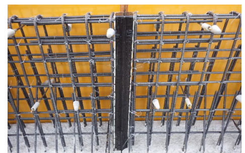
写真-3 ひび割れ誘発目地材
