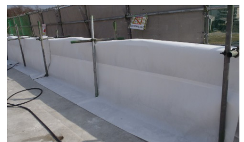
写真-4 壁高欄追加養生状況
