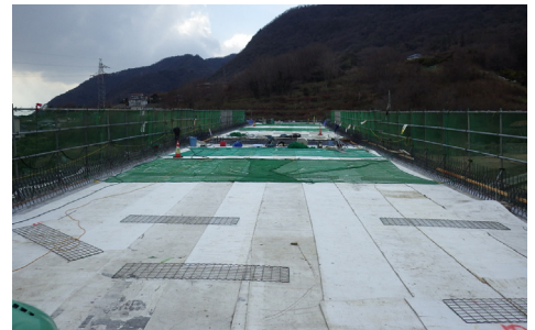
写真-2 保水・保温マット敷設養生
