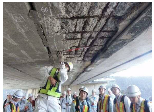
写真-3 橋梁の実習(フィールドワーク)の様子
