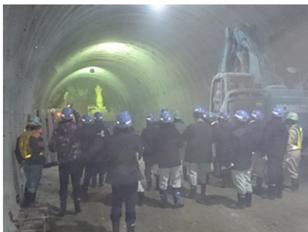
掘削状況視察（休山トンネル）
