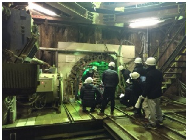
掘削状況視察（水道トンネル）
