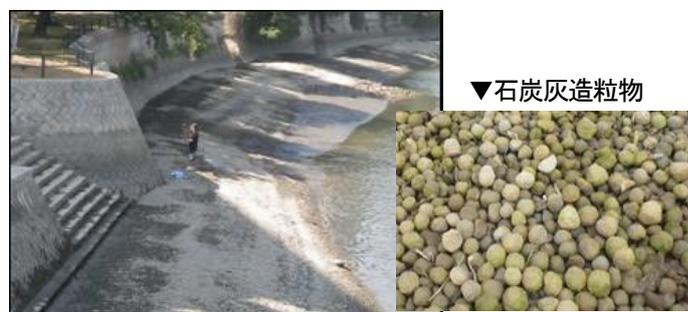
写真-2 石炭灰造粒物による河岸整備の状況
