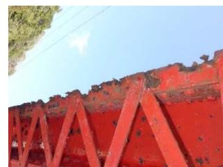
(b) 下フランジの断面欠損
