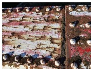
(a)添接板縁端部の溝状腐食
