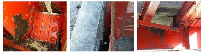
写真-3 水抜き孔直下の腐食
