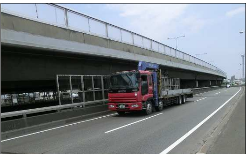
写真-2 大型車両の走行状況
