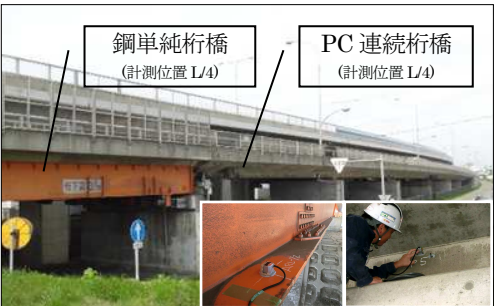
写真-1 計測橋梁
