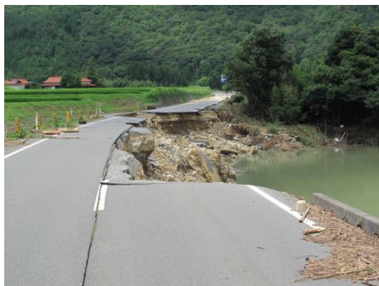
図1 阿武川の湾曲部での被災事例 2)
